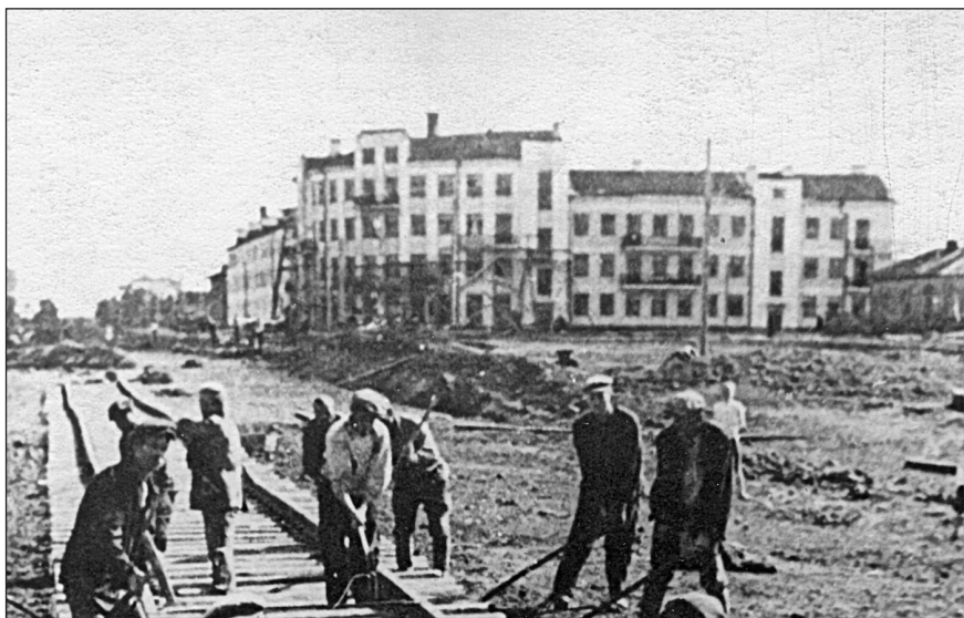
Строительство железнодорожной линии на улице Октябрьской города Кирова. 1940-е гг.
