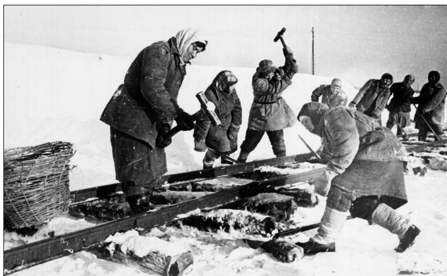
Строительство узкоколейной железной дороги до Каринторфа
